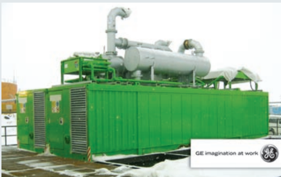
Применение нефтяного попутного газа на базе газовых двигателей Jenbacher Северная Нефть, Россия Электрическая мощность 3,775 кВт, тепловая мощность 2,196 кВт
