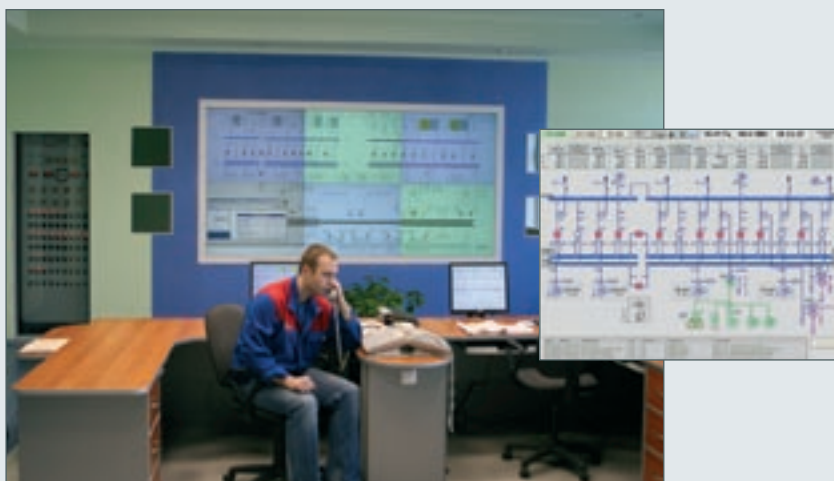
Автоматизированная система оперативного диспетчерского контроля ГРЭС ОАО «Харанорская ГРЭС» п. Ясногорск, Читинская область.
